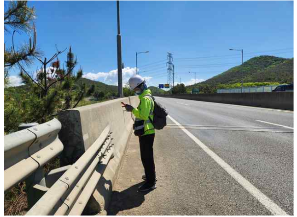
도보점검을 이용한 부재치수 현장측정
