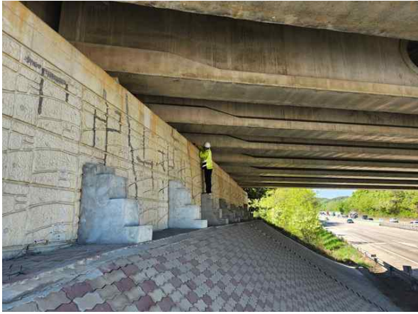
도보점검을 이용한 부재치수 현장측정
